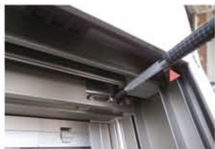
1) 上部止め金具を締める。
