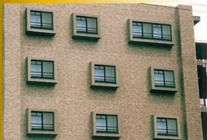
● マンション等施工外観
